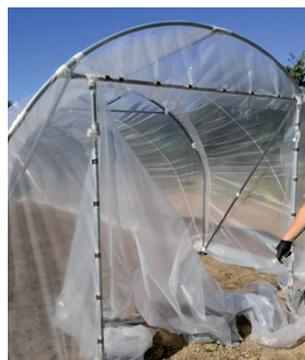
Legen Sie den Folienausschnitt der Tür sowie die Tür auf einen ebenen Untergrund und verclipsen Sie die Folie am Türrahmen mit den 27mm Ohr-Clipsen wie im Foto gezeigt (Folie sollte sehr straff gezogen sein). Die überschüssige Folie kann dann abgeschnitten werden und die Tür eingehängt werden.
