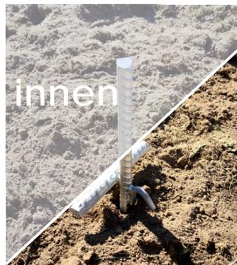
Die Haken für die Spannschnur müssen am Ende nach außen gerichtet sein. Achten Sie beim Eindrehen der Bodenanker darauf, dass diese tief genug in den Boden eingedreht werden und dabei waagrecht auf einer Höhe sind.
