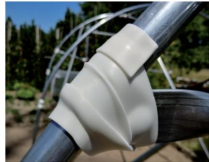
Kleben Sie alle scharfkantigen Elemente von Firststangen, Windverband und Tür sowie die Schrauben mit dem mitgelieferten Schaumstoffklebeband ab, um die Folie zu schützen.
