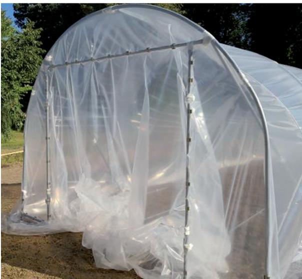
Ziehen Sie die Folie zuerst an einer, dann an der anderen Seite straff. Befestigen Sie sie zunächst auf der Vorderseite, dann auf der Rückseite jeweils an den unteren Pfetten (32 mm) sowie an Türpfosten (32 mm) und Türfirst (27 mm) mit den Ohr-Clipsen. Die Folie kann optional an den Tunnelbögen verclipst werden. Überschüssige Folie kann zunächst nach innen umgeschlagen und später ggf. abgeschnitten werden.
