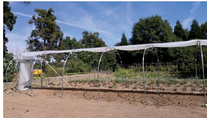
Ziehen Sie die Folie in Längsrichtung vorsichtig über das Stahlgerüst und beginnen Sie dann, die Folie **vorsichtig** auszubreiten, indem Sie zunächst langsam eine Seite der Folie und dann die andere Seite entfalten. Achten Sie darauf, dass keine Knickfalte entstehen, um Risse in der Folie zu vermeiden.
